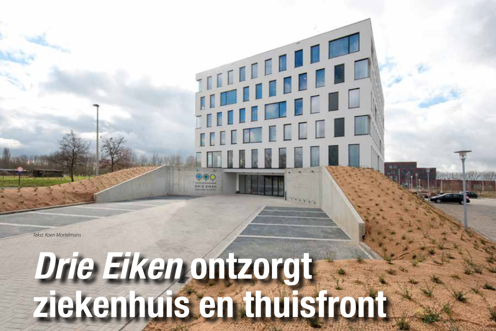
< Het gebouw telt zes niveaus. De begane grond is in een bestaande heuvel geplaatst. De alternerende ramen vermijden de perceptie van een ziekenhuis. (Foto: Llox.)
