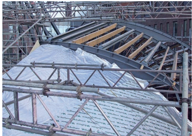
Op het voorste vak zijn de dampdichte folie en de PIR isolatieplaten gelegd.
