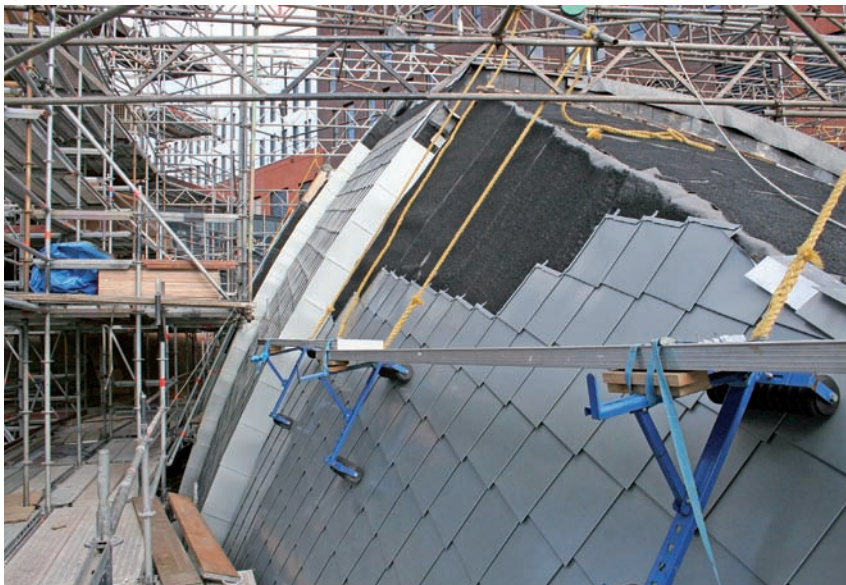
De losagnes zijn zonder uitlijning verwerkt. Onder de losagnes is de ventilatiedeken te zien.
