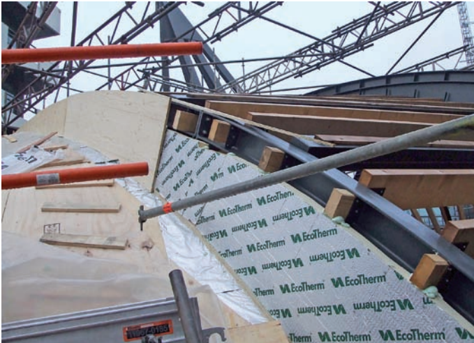
De opstaande kanten, door het hoogteverschil tussen de segmenten, worden dichtgezet.
