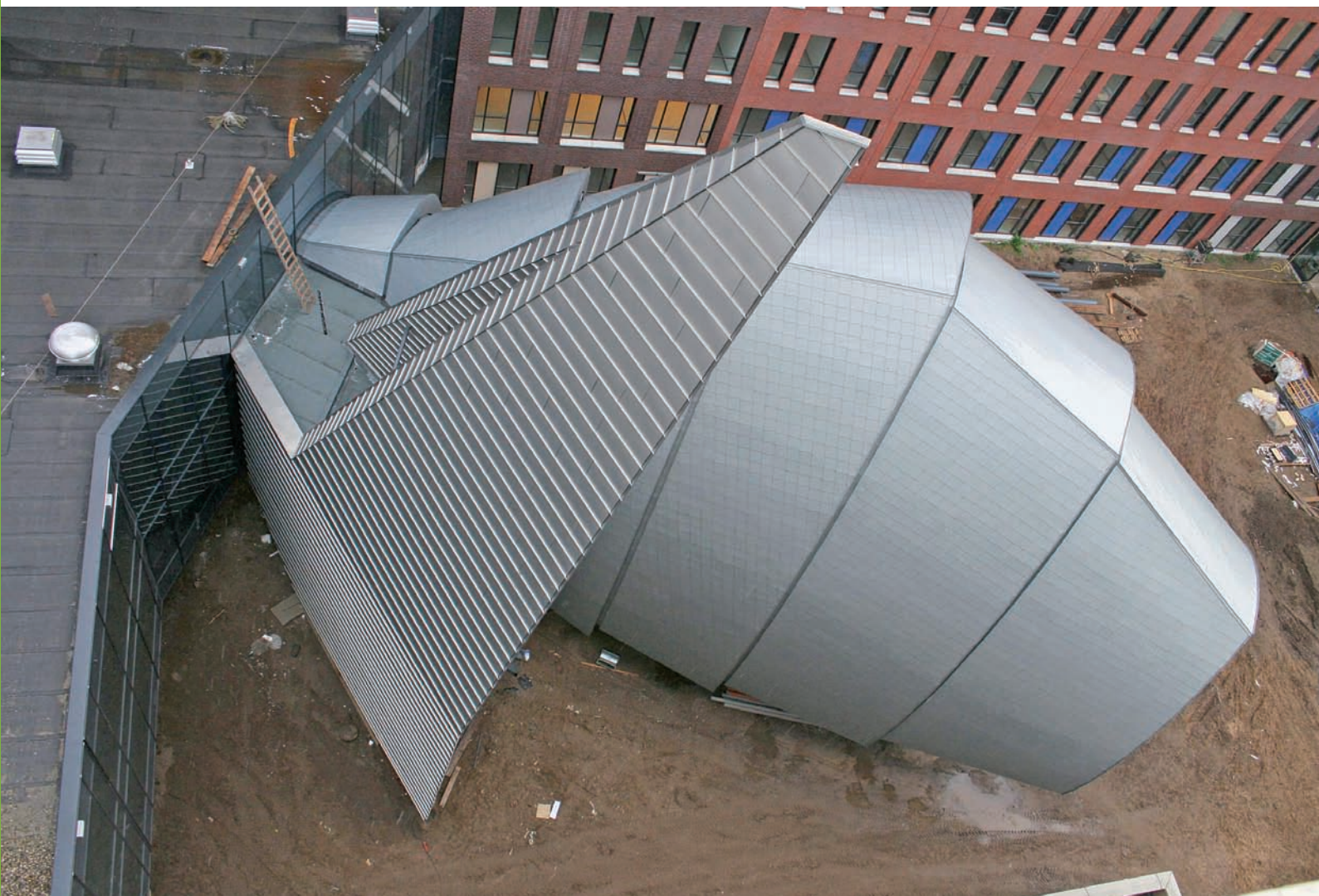
De toren bestaande uit twee schuinstaande vlakken is ook geheel bekleed met losagnes.
