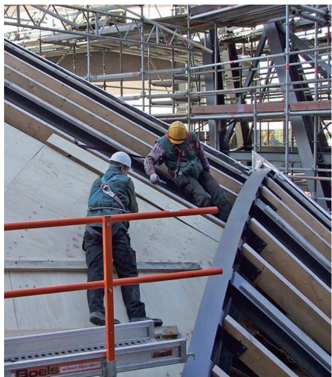
De eerste van twee lagen triplex wordt vastgespijkerd op de ingebrachte gordingen.
